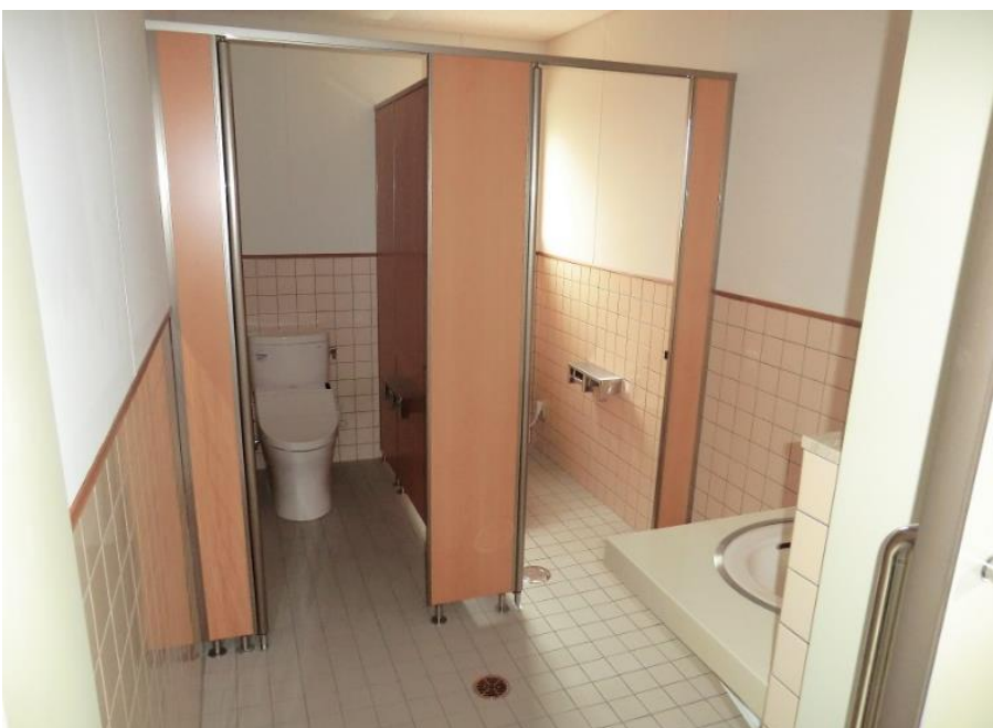
⑨ 便所棟(内部)
